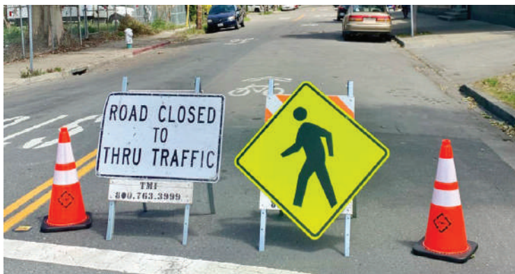
Figura 12. Ejemplo de señalamiento vertical. Fuente Nacto 2020"
