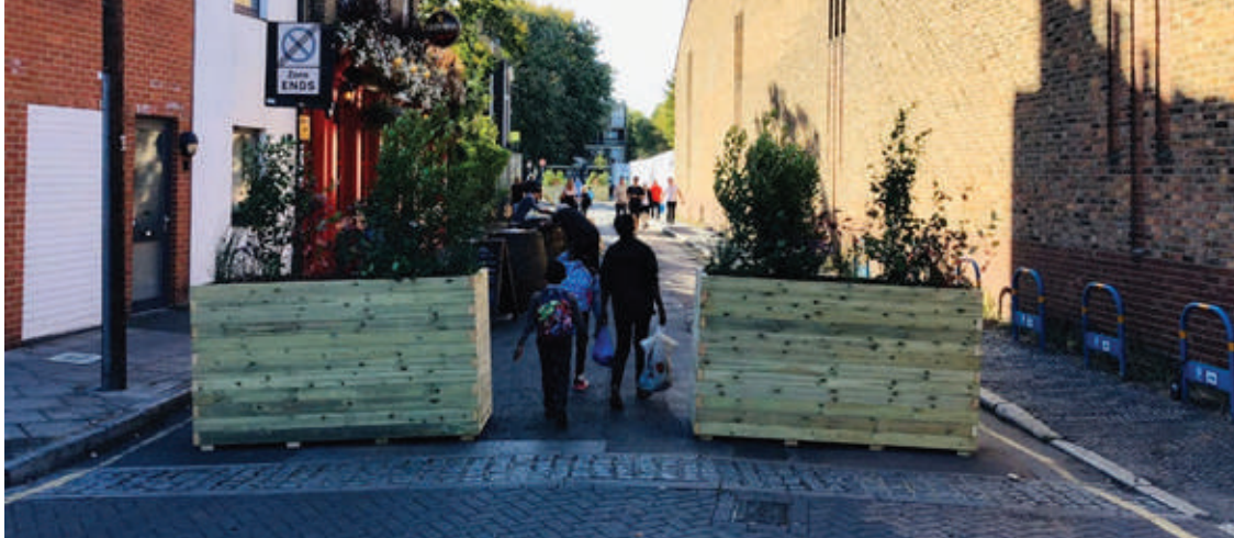
Figura 32. Instalación de barreras para peatonalizar una calle, Lewisham, Londres. (Fuente: Consejo de Lewisham, Londres)
