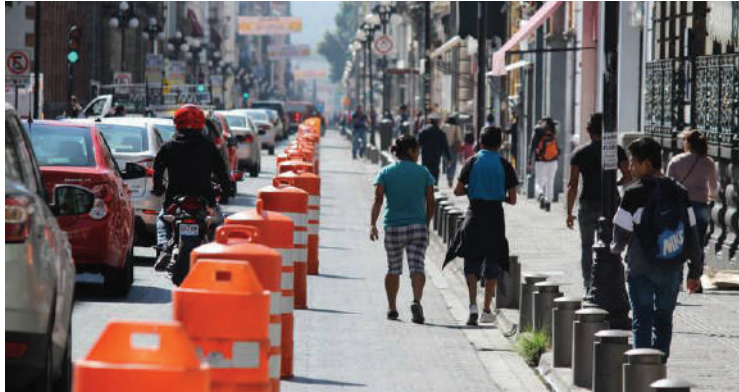
Figura 11. Ejemplo de confinamiento para extensión de banqueta. Fuente El Sol de Puebla Agosto 2018
