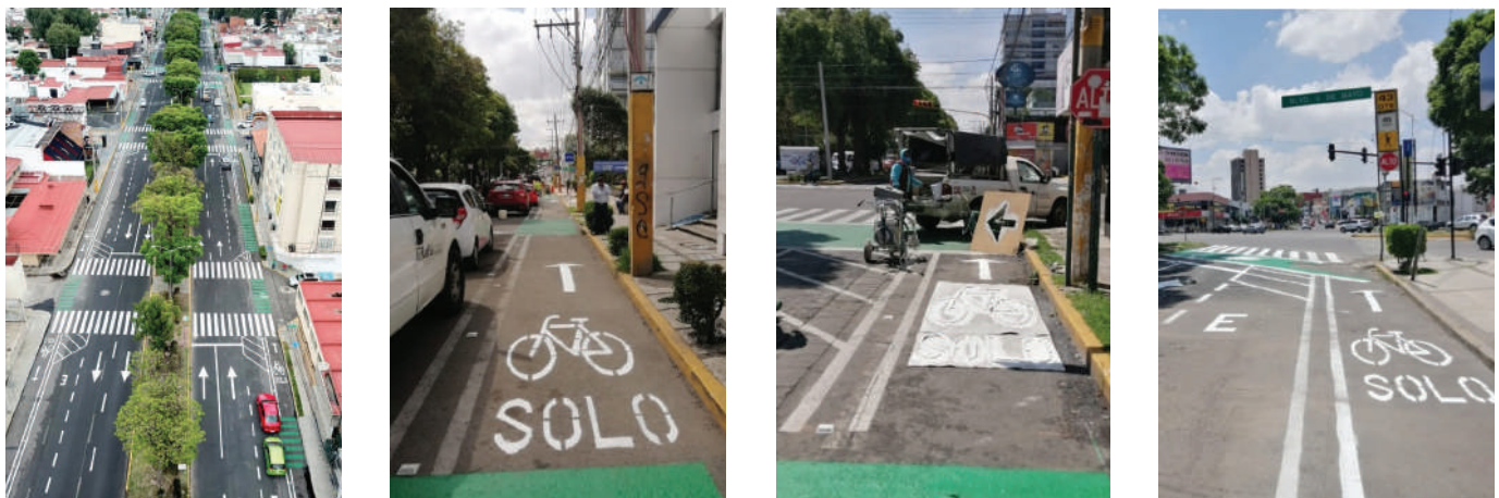
Figura 28. Ciclovía emergente confinada por cordón de estacionamiento, Av. 43 Poniente, Puebla. (Fuente: Secretaría de Movilidad de Puebla)
